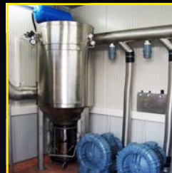
AD PRODUZIONE ASPIRAZIONE CENTRALIZZATA
